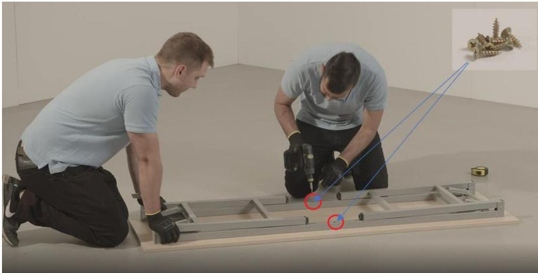
4. Klappen Sie den Sockel aus und befestigen Sie ihn mit vier Schrauben an der Tischplatte.
